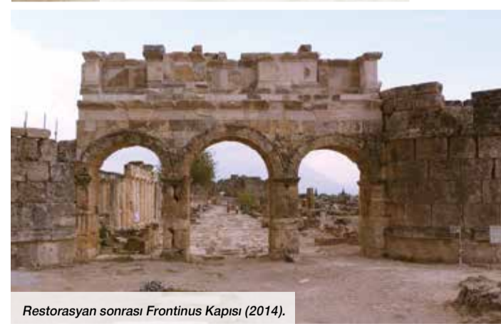
Restorasyon sonrası Frontinus Kapısı (2014).
