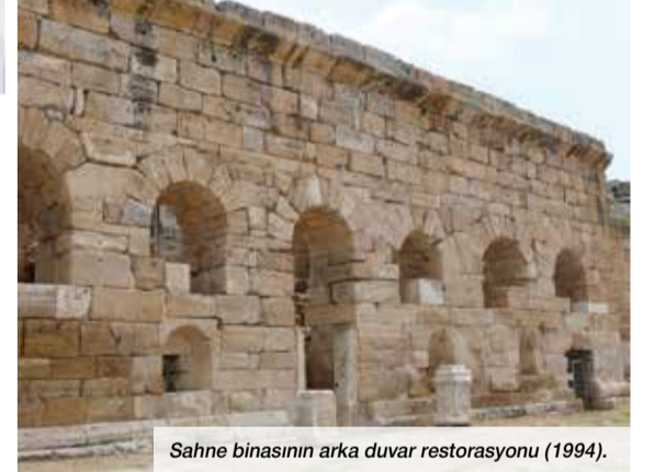
Sahne binasının arka duvar restorasyonu (1994).
